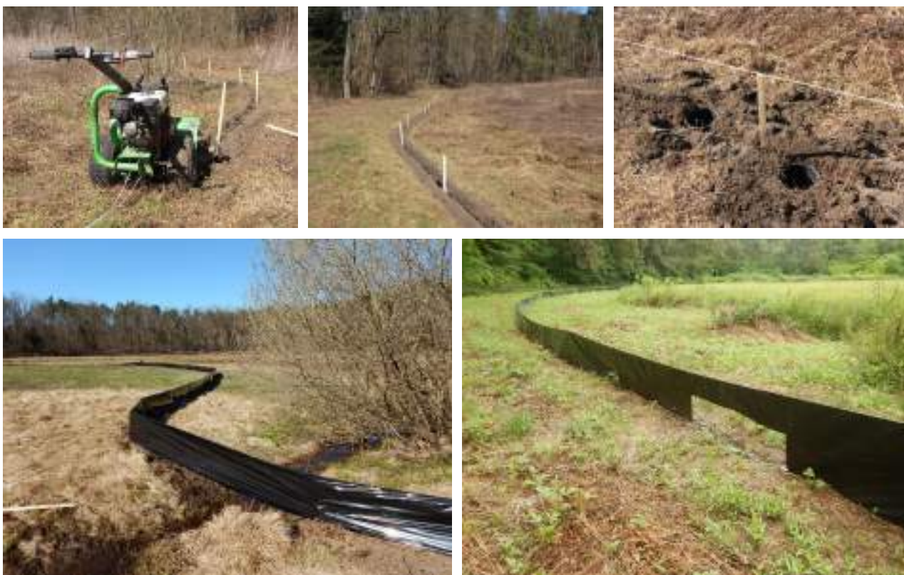
Figura 5. Fasi costruttive e di una barriera completa con trappole a caduta. In basso a destra il varco aperto fra il periodo di migrazione degli adulti e quello dei metamorfosati di Pelobate fosco per consentire la circolazione di altra fauna, richiuso al momento della ripresa delle attività di monitoraggio.
