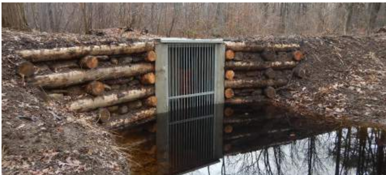
Figura 16: Fasi di costruzione di una chiusa Idobat, tipo Peverascia, e risultato finale. Negli esempi la sua prima applicazione presso l'acquitrino della Peverascia (Arsago Seprio) ed in seguito alla palude della Moriggia (Gallarate)
